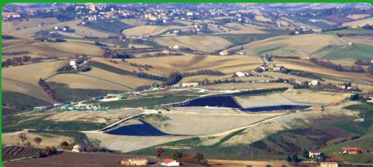
Foto 1 Box 16 Colore originale delle guaine poste sul fondo delle vasche per evitare la contaminazione dei terreni sottostanti la discarica.
