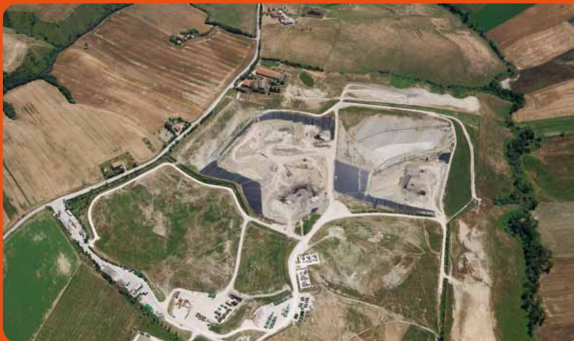
Foto 1 Box 20 Vista d'insieme dell'impianto.
