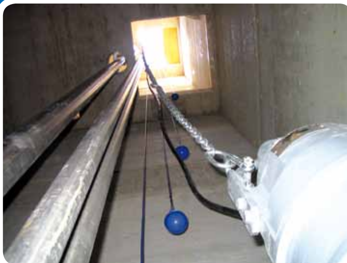
Foto 1 box 8 Pompe ad immersione Estrazione del percolato vista dal fondo interno.
