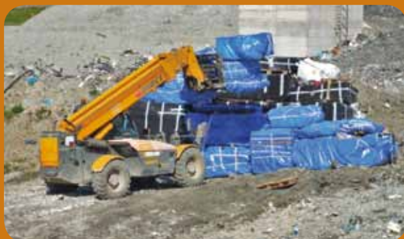
Foto 1 Box 9 Smaltimento controllato in "Celle monodedicato" di rifiuti contenenti amianto - Eternit -
