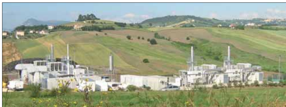
Nelle foto: una panoramica della discarica; la centrale a Biogas della So.Ge.Nu.S Spa
